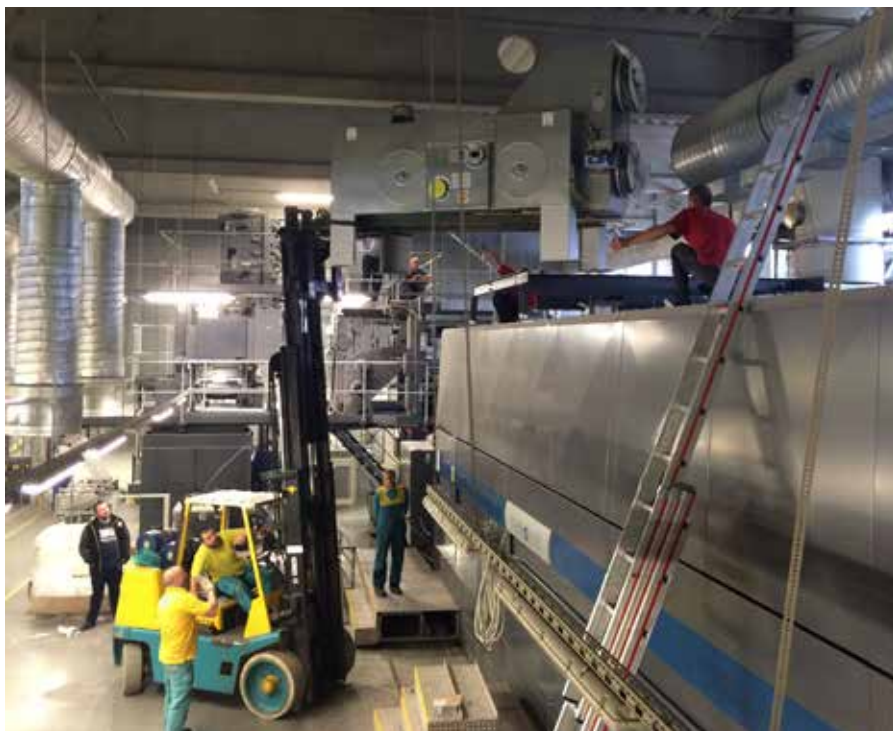
Obr. 2 Inštalácia rekuperátora tepla
