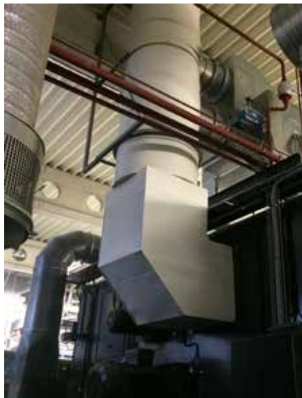
Obr. 5 Rekuperátor na tlačiarenskom stroji
